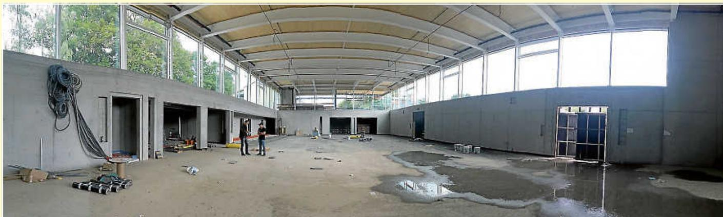
Nachdem die Verglasung eingebaut wurde, konnte letzte Woche das Gerüst abgebaut werden. Als Nächstes wird in den Umkleideräumen der Estrich verlegt.
