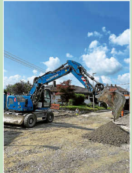
Die Arbeiten in der Talstraße dauern noch den Juli über an.
