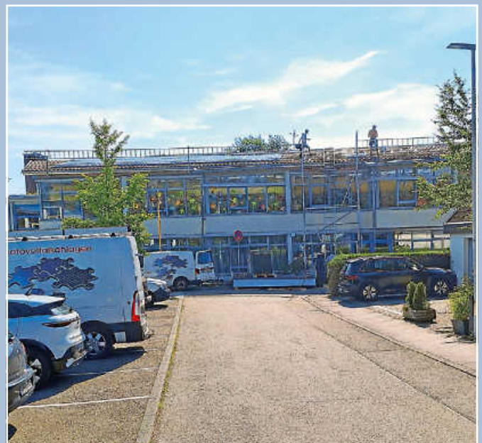
Auf dem Dach der Apfelbachschule laufen die Arbeiten noch.
