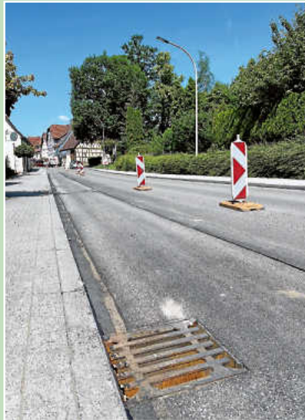
Der Grund für die Arbeiten auf der Ortsdurchfahrt war die Straßenentwässerung.
