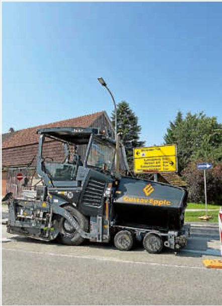
Zuletzt war in der Winnender Straße ein großer Asphaltfertiger im Einsatz.
