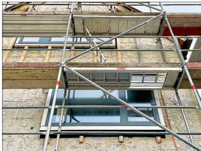
Vor allem bei größeren Sanierungen rechnen sich Baubegleitung und Sanierungsfahrplan. Foto: LEA
