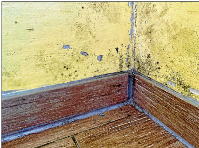
Die Ecken von Räumen sind klassische Wärmebrücken, an denen sich häufig Schimmel bildet. Foto: LEA
